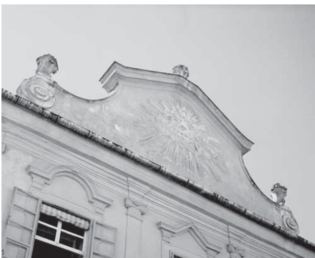
12. Rizalit pročelja palače Zagrebačkog kaptola (1760.). The Zagreb Kaptol Palace in Varaždin, risalit (1760.).
