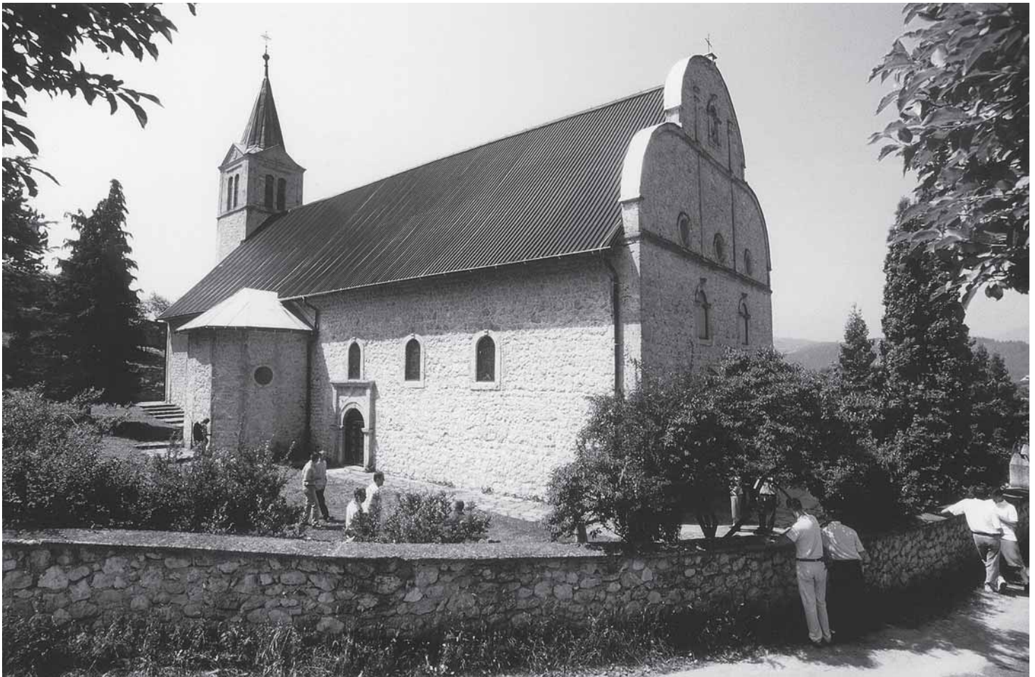
Ovčarevo, crkva sv. Mihovila, južna strana Ovčarevo, St Michael, view from the south
