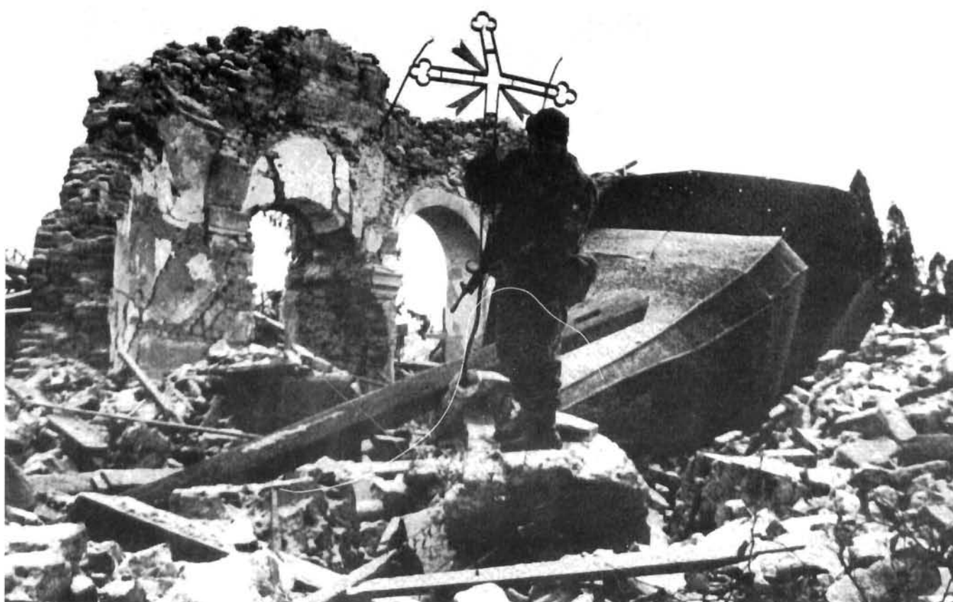
Kako je Hrvatska gubila svoje nasljeđe: crkva u Lipiku, 19. stoljeće, nakon srpskog razaranja. Destrukcija kao način življenja. How has Croatia been losing its heritage: the church in Lipik, 19th cent., after being destroyed by the Serbs. Destruction as a way of life.
