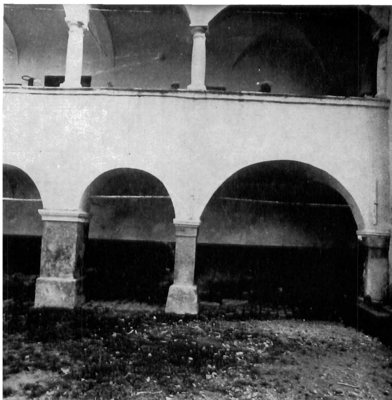
Dvorac Horvacka južni ugao križni svod u obje etaže, fotografija: Vladimir Marković.
