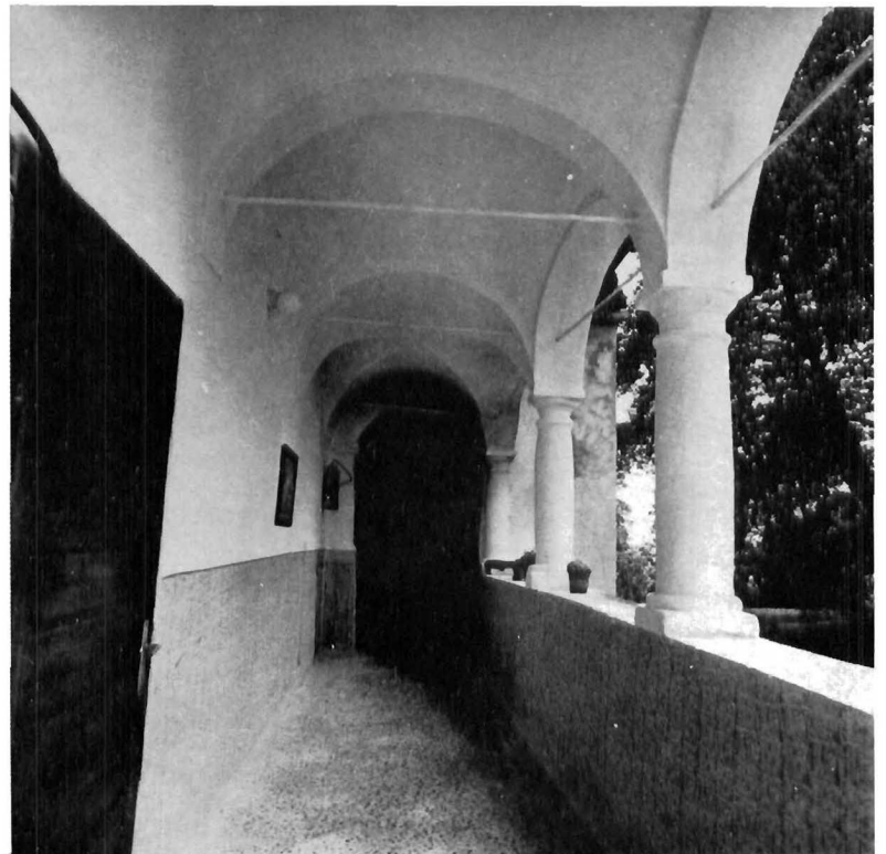
Dvorac Horvacka južni travej hodnika sa križnim svodom, fotografija: Vladimir Marković Horvacka Castle, southern bay of the corridor with cross-vault, photo by Vladimir Marković
