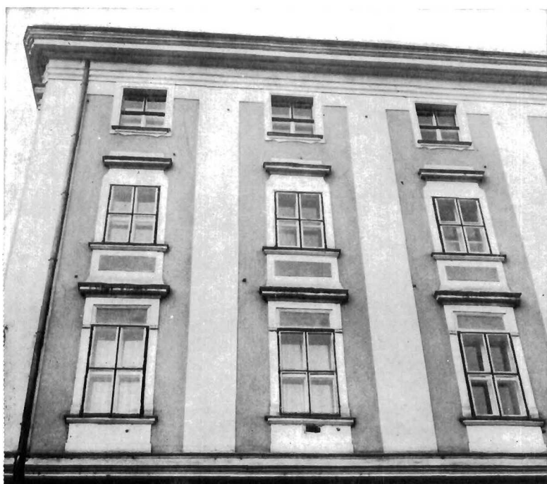
J. Emanuel Fischer von Erlach i A. E. Martinelli: bolnica u Budimpešti, pročelje, detalj
