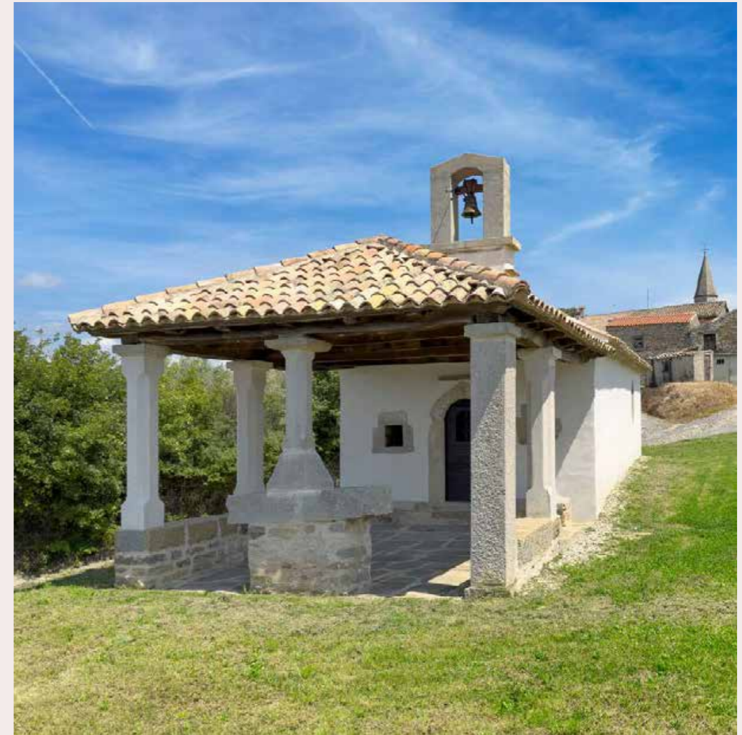
Draguč, kapela sv. Roka nakon obnove
