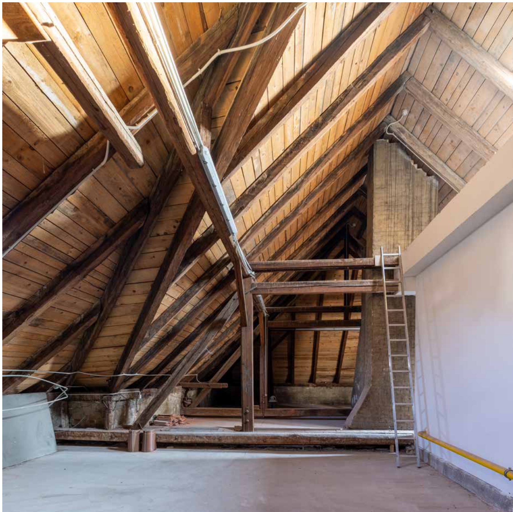
Potkrovlje pročelnog (sjevernog) krila
