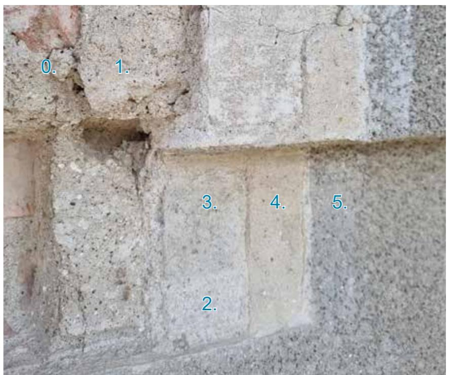
0,5 cm, relativno je ravnomjernog nanosa koji varira od 0,7 do 1,5 cm. Profilirani istaci su srednje fine završne obrade, dok je grublja zrnata obrada na ravnim zidnim plohama dobivena obradom poluosušene žbuke najvjerojatnije četkanjem. Žbukani slojevi trusne su strukture i oslabljene međuslojne adhezije. Vidljiva je podbuholost žbukanih slojeva i veće pukotine, koje prodiru dublje do grade. Izvorni
