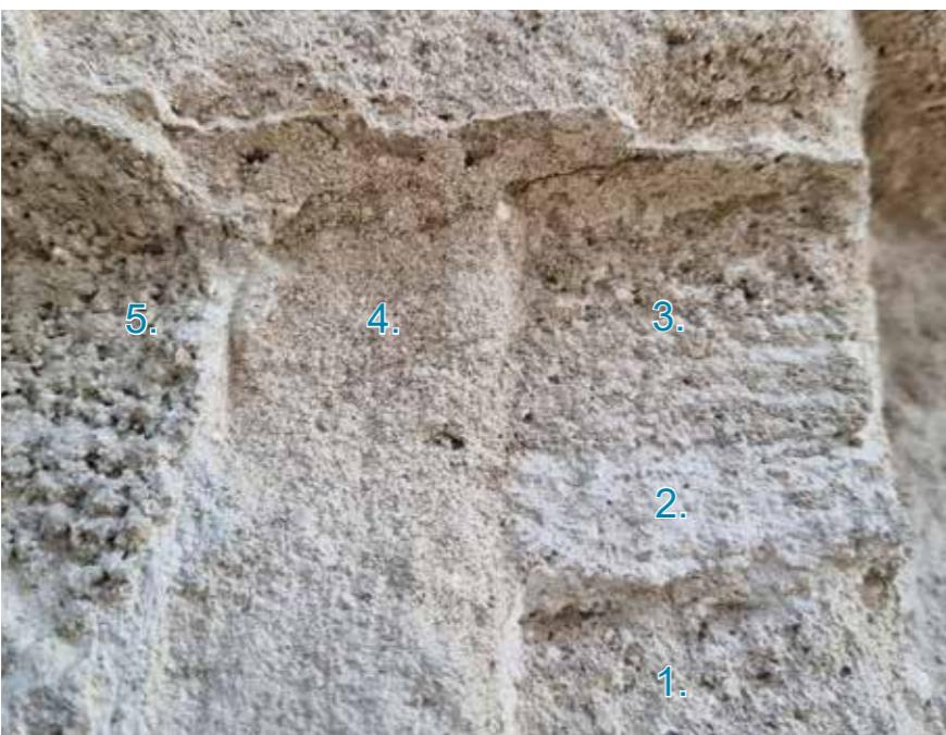
ne plohe i čini nosilac za arhitektonsku plastiku. Izvorna podložna žbuka sivog tona punjena je kamenim agregatom riječnog podrijetla, granulacije od 0 do 2 cm. Sadrži udio krupno mljevenog ugljena i nedovoljno umiješano gašeno vapno, a moguć je i udio cementnog veziva. Debljina nanosa varira od 1 do 3 cm. Završna žbuka sadrži veći udio vapnenog veziva i moguće bijeli *Portland* cement. Punjena riječnim pijeskom i sitnim lomljencem, granulacije od 0 do
