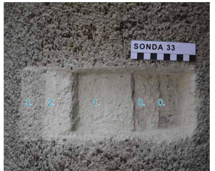
posljednjoj većoj obnovi. U nultom sloju sonde prikazana je armiranobetonska građa stupa izvedena *in situ* drvenom oplatom. Zatečena je u dobrom stanju, čvrste strukture, bez vidljivog osipanja površinskog sloja gradivnog materijala.
