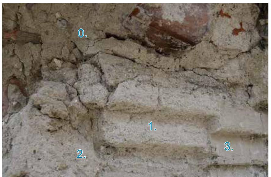
1 cm, sastavom odgovara izvornoj podložnoj žbuci te se razlikuje od zaključne žbuke koja sadrži veći udio gašenog vapna i moguće bijelog *Portland* cementa. Izvorni nalič u sondi prisutan je u manjim tragovima te je većim dijelom degradiran nanosom žbukanih slojeva u obnovi.
