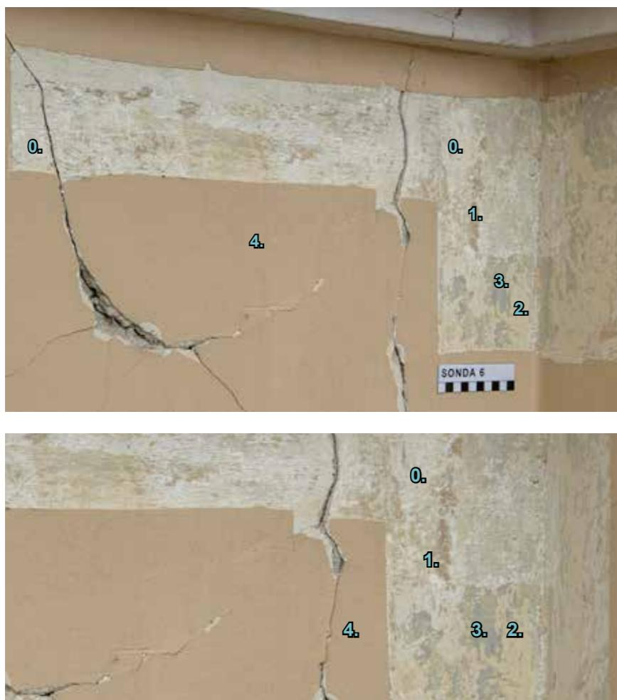
Sondom je istražen polikromni nalič s bordurom, koji je otkriven u prethodnoj sondi. Iako je na istraženoj poziciji zatečen u izrazito lošem stanju, kutno se nazire vertikalna bordura svjetlosmeđe boje; izvedena je na podlozi sive boje toplog tona.
