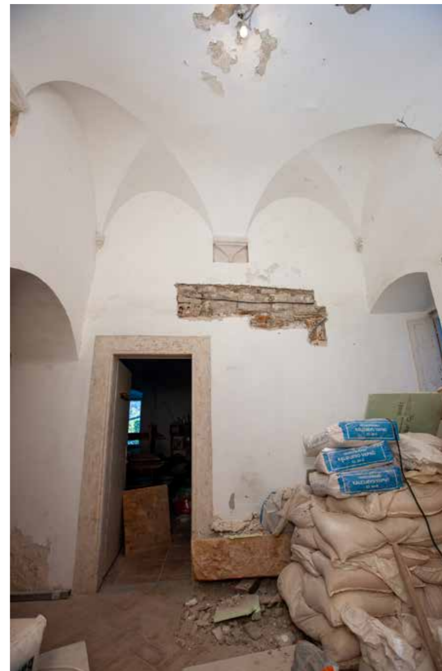
Prostorija uz stubište sa zrcalnim svodom sa susvodnicama
