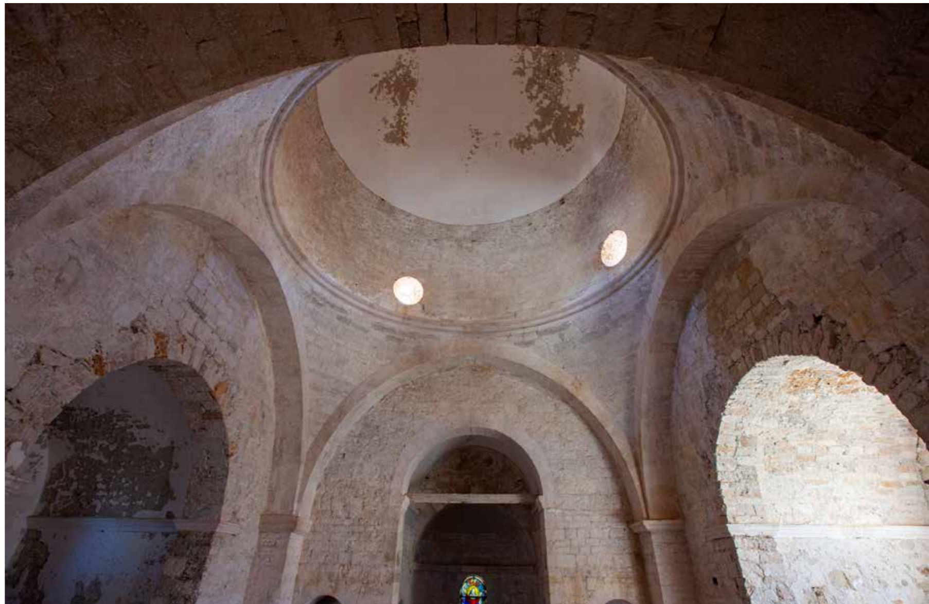
Romanička crkva, pogled na kupolu
