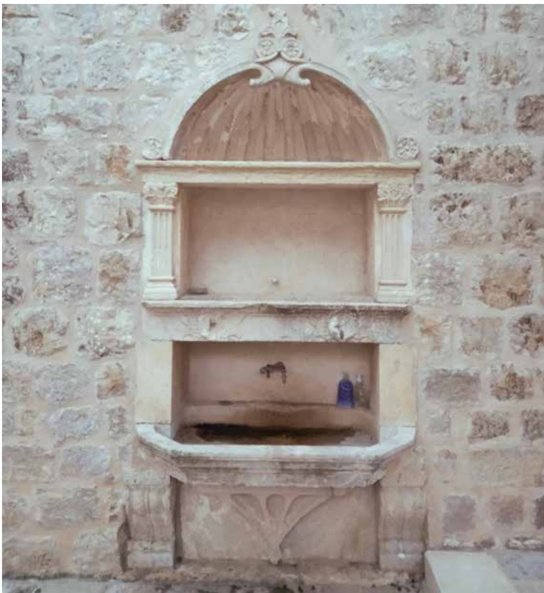
Južno krilo, sjeverno pročelje, naknadno ugrađeno pilo
