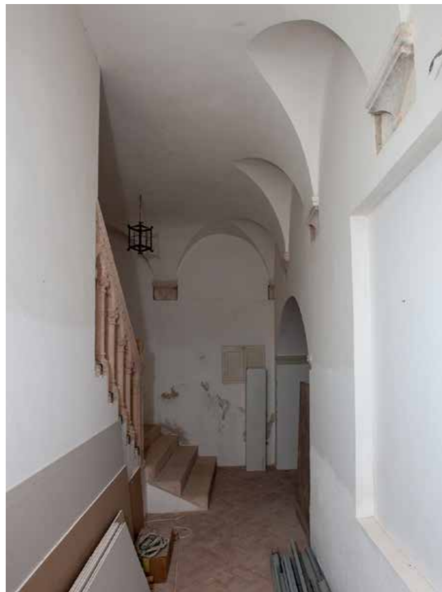
Svodovi uz stubište, detalji
